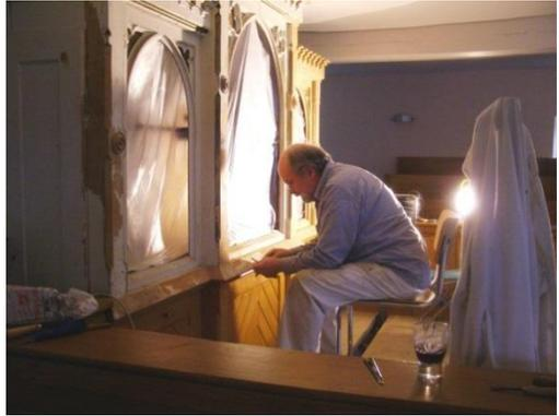
In dieser Zeit wurde durch die Fa. Sauer auch die Mechanik der Orgel instandgesetzt, alle Pfeifen ausgebaut gereinigt, repariert und die Orgel neu gestimmt.
